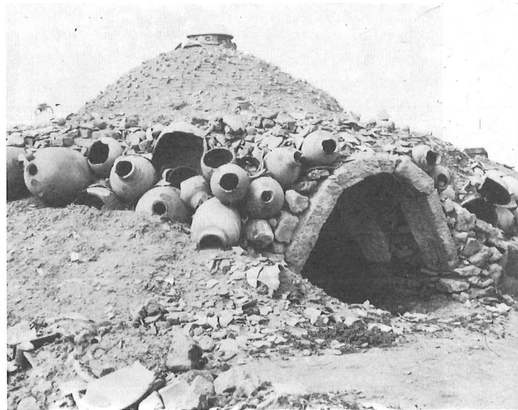
Ph. III.5 Partie supérieure d'un four à poteries «jeffây». Remarquer la porte d'enfournement.
