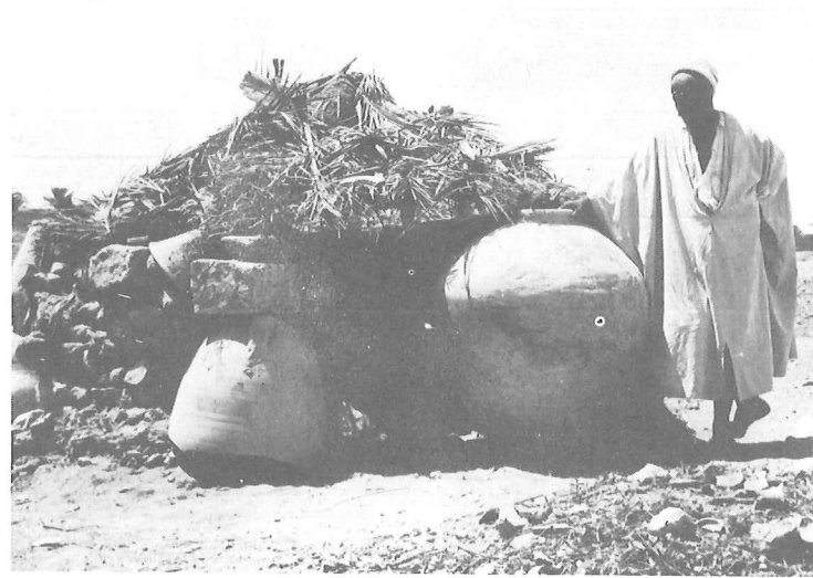
Pb. IV.22 Hors-d'usage, le «dûh» vient servir d'élément de support dans la construction des huttes ( cf. chap. XI ).
