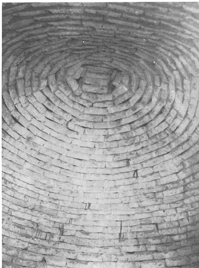
Ph. III.4 Sommet et coupole d'un four. Remarquer la technique de construction et la façon de claver la coupole.
